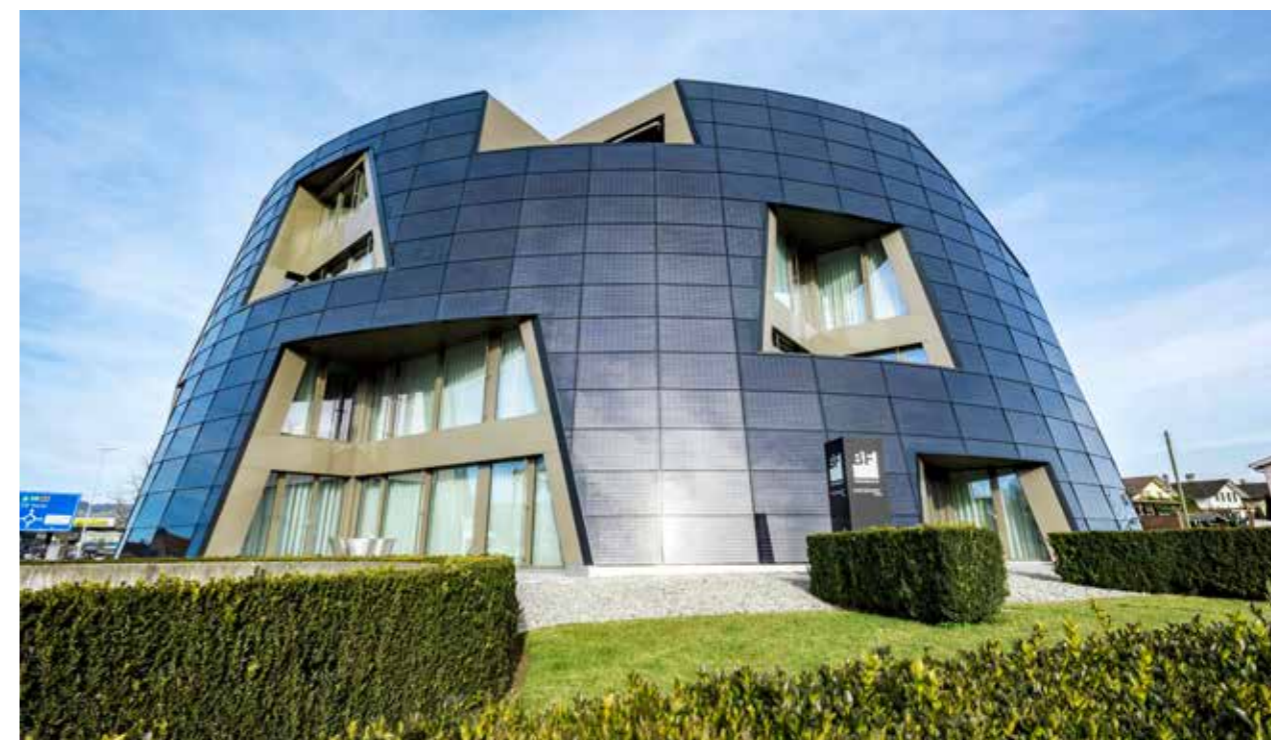
Ein echter Hingucker: Das Bürogebäude der BF architekten sursee AG. Erneuerbare Energie und Feng-Shui stehen hier hoch im Kurs. Foto: zVg
