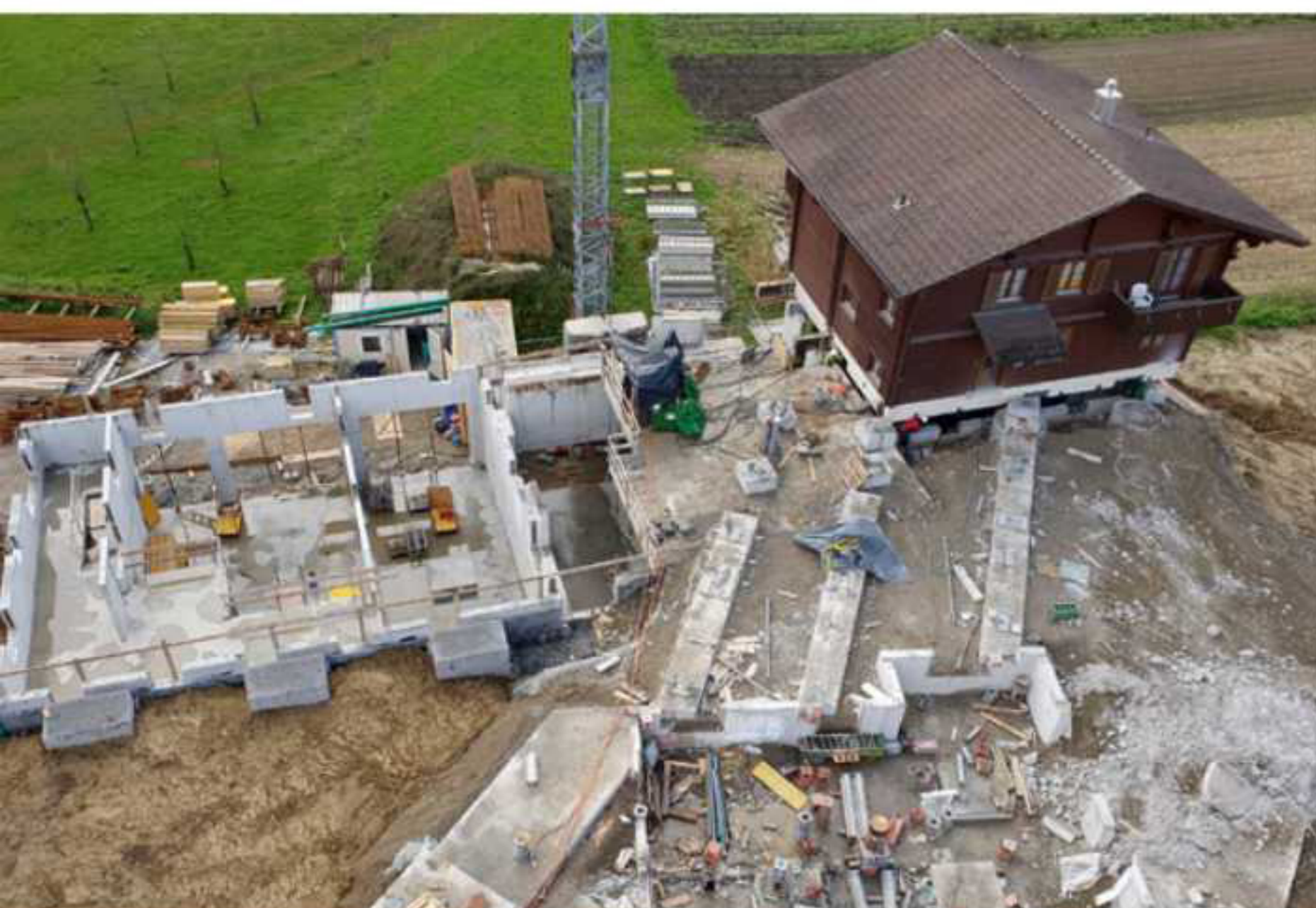
Aus der Vogelperspektive: Das kleinere Haus wurde bereits erfolgreich verschoben.
