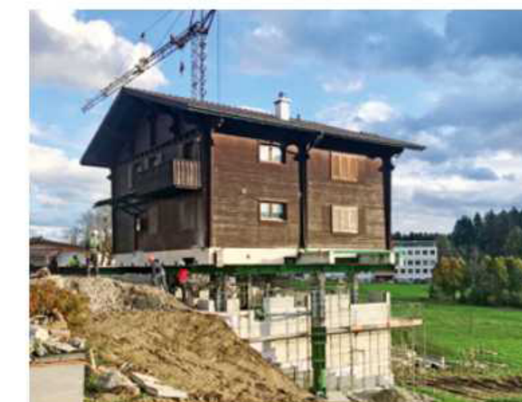
Rund 23 Meter weiter wird das Haus auf den Neubau abgesenkt.
