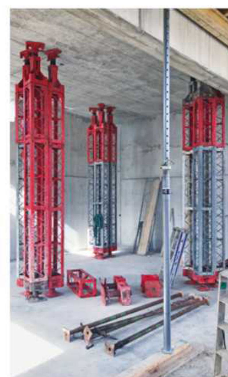
Massiv: die zahlreichen provisorischen Schwerlaststützen im Neubau
