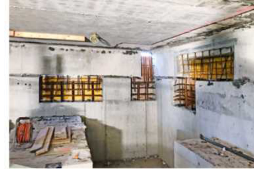
Neubau und Bauernhaus werden statisch verbunden und schliesslich ausbetoniert.
