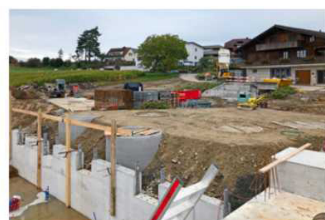
Wandöffnungen im Neubau ermöglichen die statische, kraftschlüssige Verbindung von bestehenden und neuen Baustrukturen.
