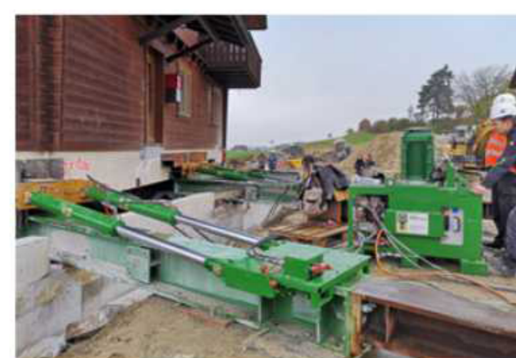
Die Verschiebung auf den Verschiebeträgern ist im vollen Gang.
