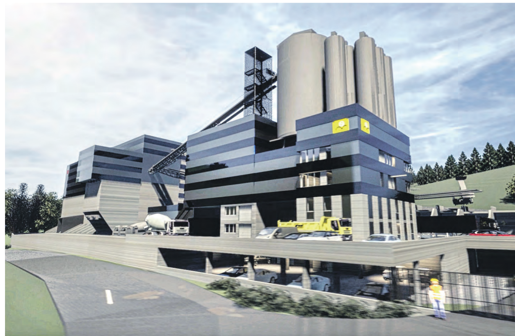
In einem dritten Betriebsteil wird Fertigbeton bereitgestellt. Die Silos enthalten Kies, Sand sowie Binde- und Zusatzmittel.
